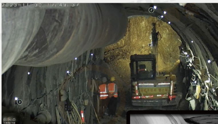
深圳某施工期 隧洞自动化监测
