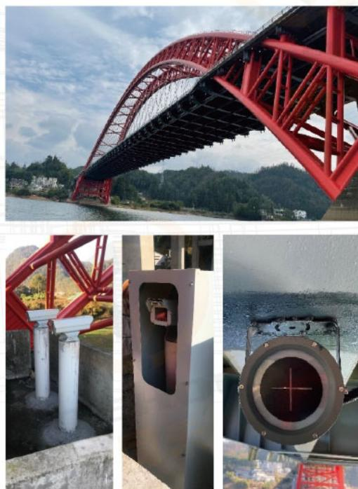
监测系统自安装以来，设备运行稳定，对桥梁主梁挠度进行了高精度测量，数据显示无明显的过大变形，该大桥结构总体处于健康状态。
