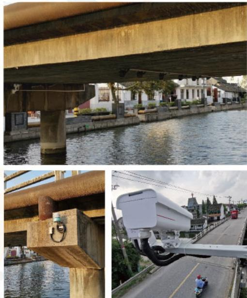
该桥梁于2021年7月5日14点54分08秒出现机器视觉智能测量仪监测的跨中挠度报警，随即启动上部抓拍摄像机。视频显示该时刻有一辆汽车驶过桥梁，荷载超标，系统成功抓拍车牌照片并识别车牌号。
